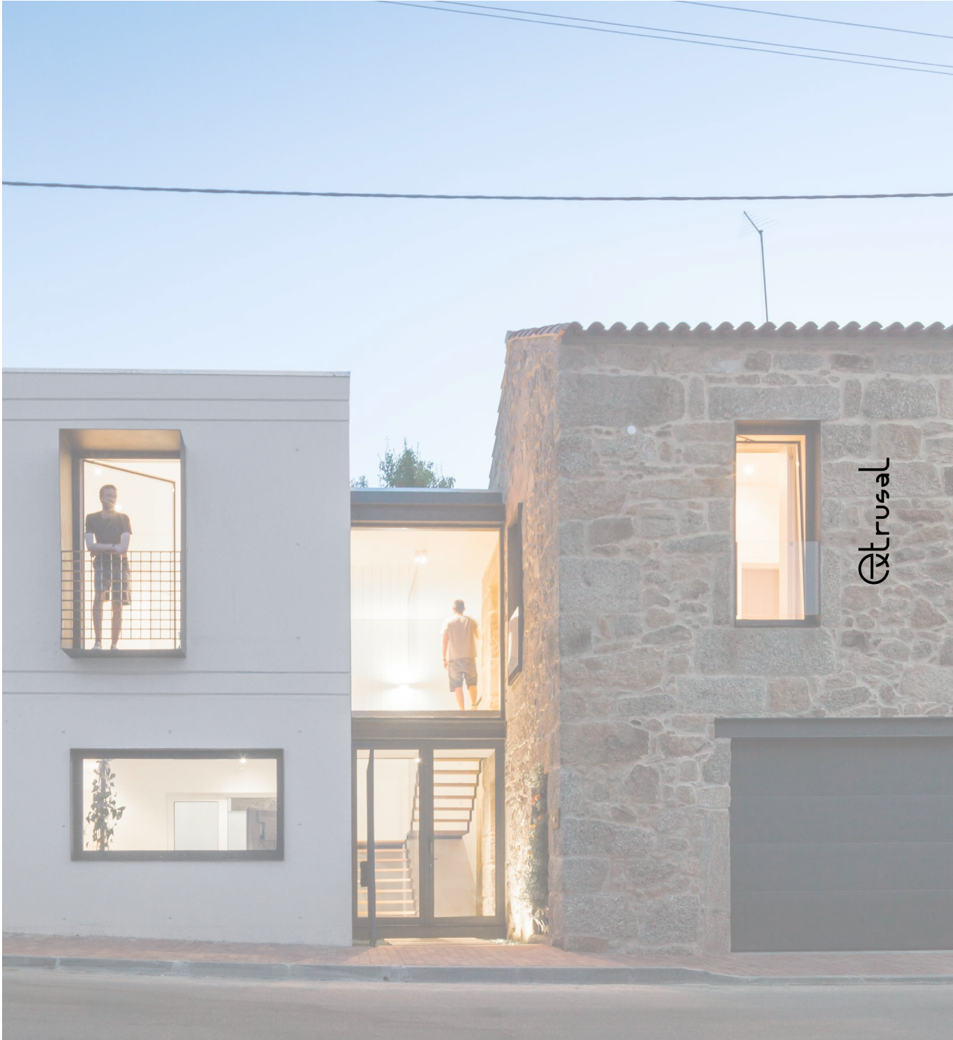
Casa JA Filipe Pina Arq. e Maria Inês Costa Guarda, Portugal
